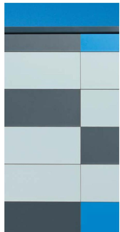
Разумеется, Modulo можно собрать с помощью алюминиевой подсистемы. Для данного типа сборки необходимо использовать 2 заклепки (5x10 мм с максимальным размером головки K14) для каждого кронштейна, если толщина алюминия в опорной конструкции находится в диапазоне от 1,5 до 3 мм (макс. длина 2800 мм).
