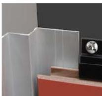
ВНУТРЕННИЙ УГОЛ С W-ОБРАЗНЫМ ПРОФИЛЕМ Рис. 1
