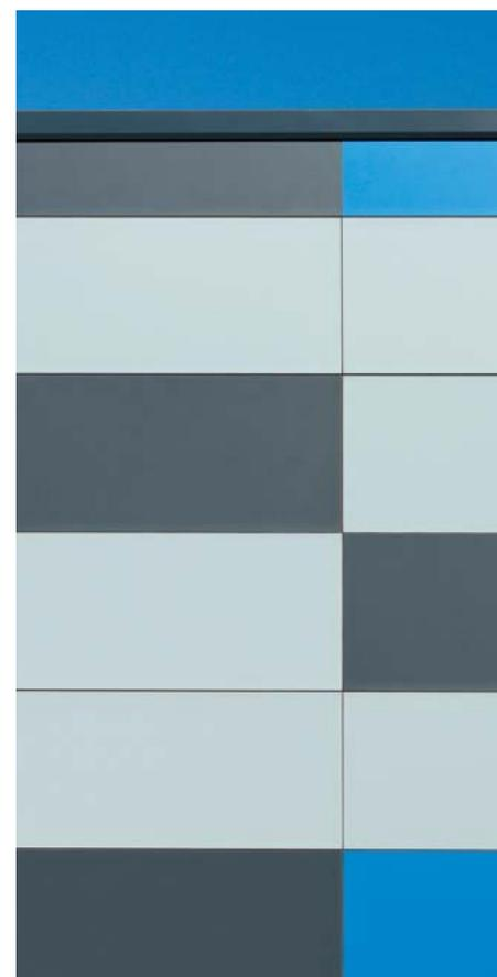
Разумеется, Modulo можно собрать с помощью алюминиевой подсистемы. Для данного типа сборки необходимо использовать 2 заклепки (5 x 10 мм с максимальным размером головки K14) для каждого кронштейна, если толщина алюминия в опорной конструкции находится в диапазоне от 1,5 до 3 мм (макс. длина 2800 мм).
